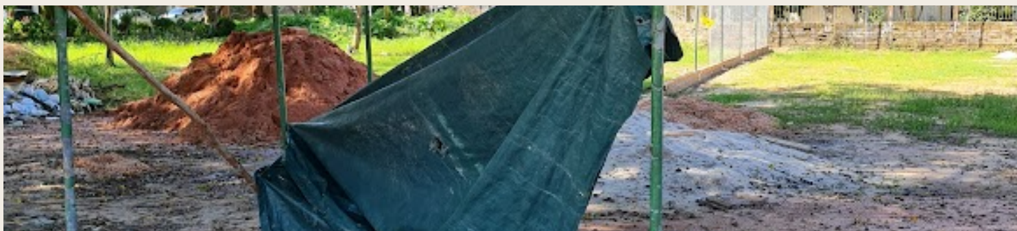
O espaço na qual seria construída uma quadra de tênis sem autorização dos associados da AMME o qual foi usurpado pela Paróquia Jesus Ressuscitado.
